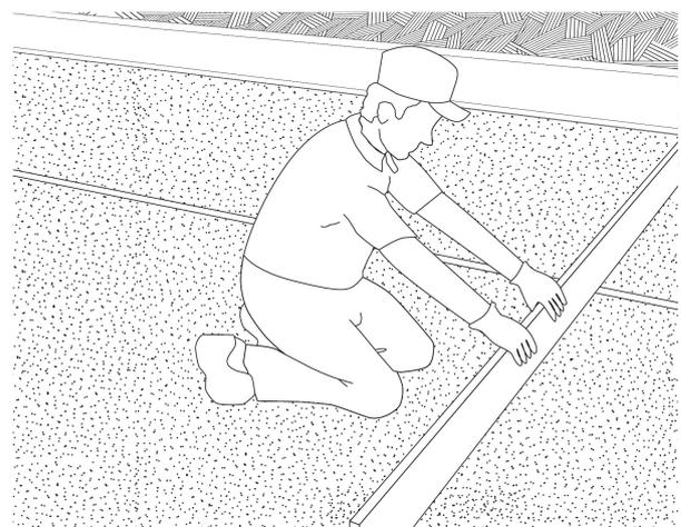
2. Spianare l'area scavata assicurandosi che vi sia almeno il 2% di pendenza (per facilitare il deflusso dell'acqua). Compattare poi il suolo con una macchina vibro compattatrice.
