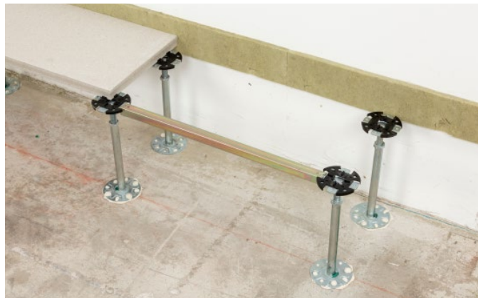
Bild 24: Assembly heavy grid rod
