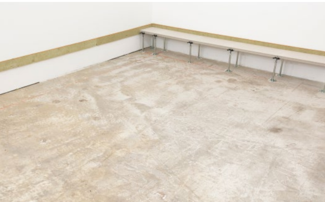
Bild 16: Installing the first row of Knauf GIFAfloor DB green panels
