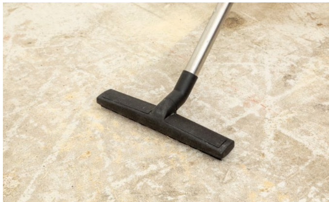
Bild 1: Clean the raw floor
