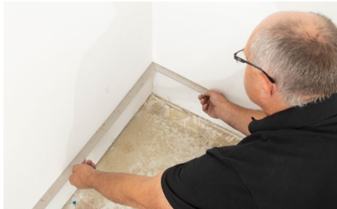
Bild 4: Checking perpendicularity
