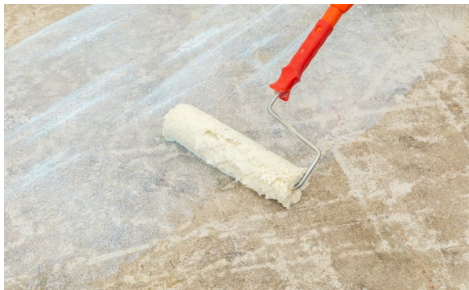
Bild 2: Prime the raw floor
