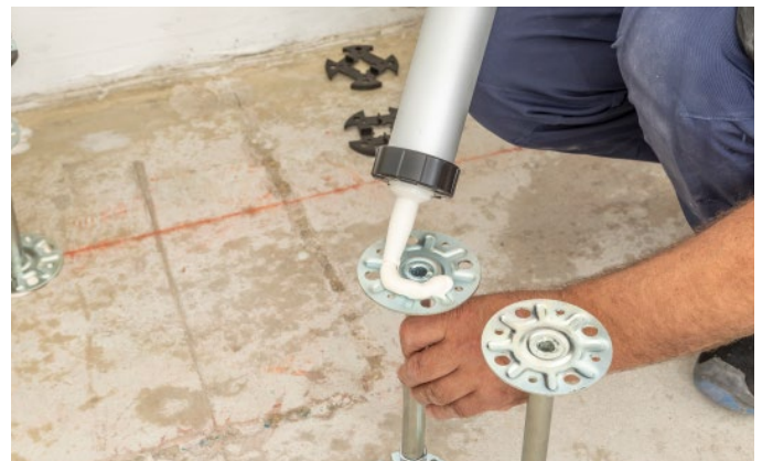
Bild 9: Apply GIFAfloor pedestal adhesive
